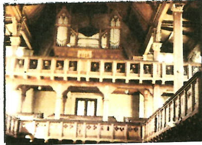
Die Orgelempore wurde entfernt
