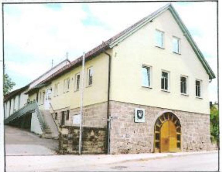
Oben: Das neue Bürgerhaus von Untersteinbach, eingeweiht 1999, mit dem Herrenkeller im EG, Foto von 2022 Links: Bericht aus der Hohenloher Zeitung 1956
