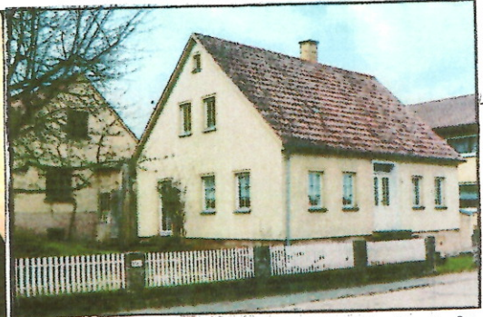
Ehemalige Kleinkinderschule in der Baierbacherstraße
