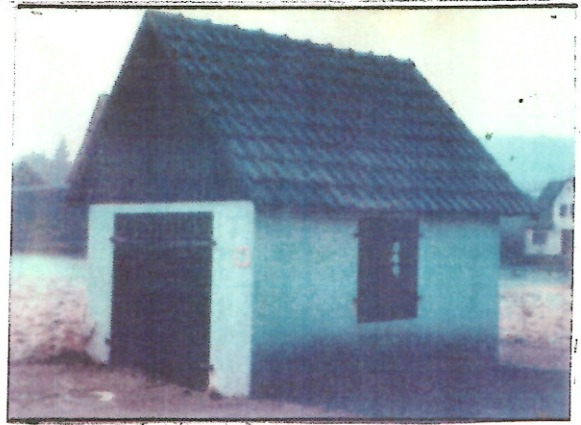
Das Waaghäuschen kurz vor dem Abbruch 1986
